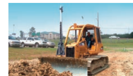
Preparación de proyectos de obras
