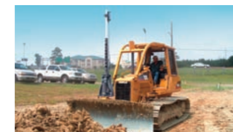
Preparación de proyectos de obras
