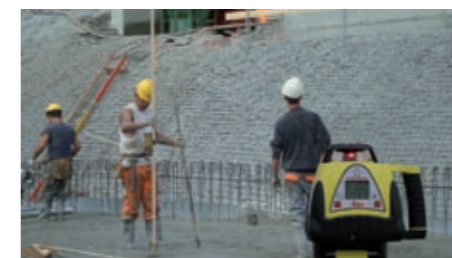
Coladas de hormigón
